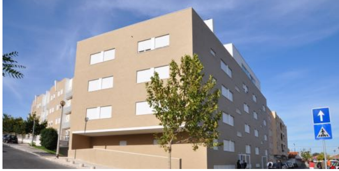
Residential Building in Famões Colmeia Azul Rua da Pinheira, Odivelas, PT | 2006 - 2008 20 apartments
